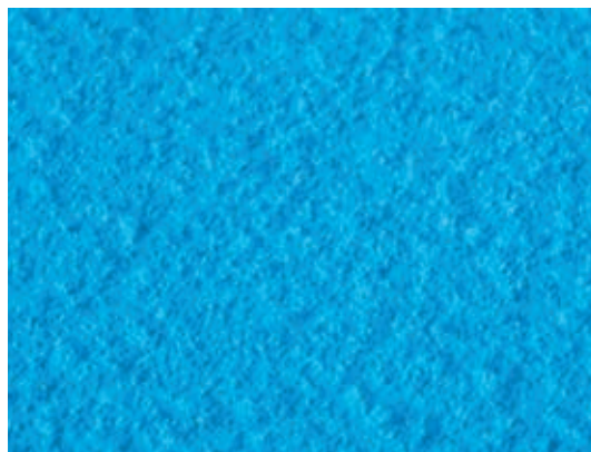
密粒舗装面での仕上がり(ローラー)の例
