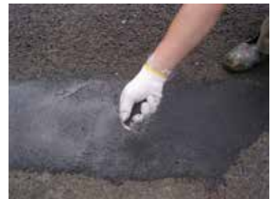
すべり止め骨材の散布
