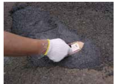
金ゴテでの施工
