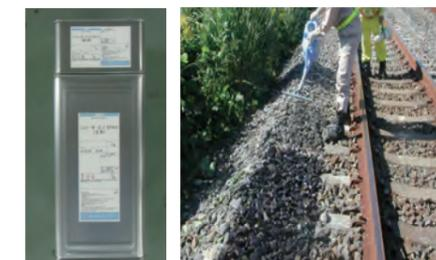
\* バラストとは、マクラギと路盤(地面)の間に敷かれる砂利、碎石により構成された軌道構造の部分。その主な役割は、マクラギをむらなく保持してマクラギに伝わる列車荷重を路盤に広く均等に分散させ、軌道構造に一定の弾力性を持たせることです。
