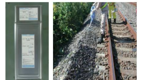
\* バラストとは、マクラギと路盤(地面)の間に敷かれる砂利、碎石により構成された軌道構造の部分。その主な役割は、マクラギをむらなく保持してマクラギに伝わる列車荷重を路盤に広く均等に分散させ、軌道構造に一定の弾力性を持たせることです。
