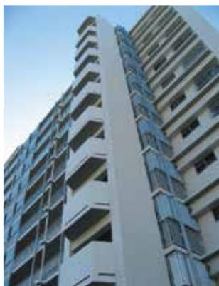
「ハイラバーウォール工法」は、高弾性、高耐久性主材と高耐候性上塗を組み合わせた工法です。
