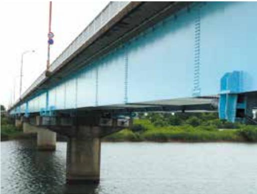
「シントーマイルドシステム」は、光化学オキシダント発生に影響の少ない弱溶剤(ミネラルスピリット)を使用し、鉛・クロムなどの有害重金属を含まない環境に配慮した防食塗装システムです。
