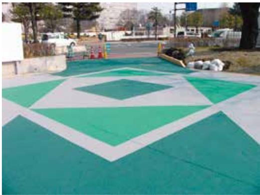
「SPリフレクターW」は、太陽光の近赤外線領域の波長を効率的に反射する特殊な顔料を配合し、アスファルト舗装などの路面温度の上昇を抑制する速乾性の水性遮熱カラー舗装材です。
