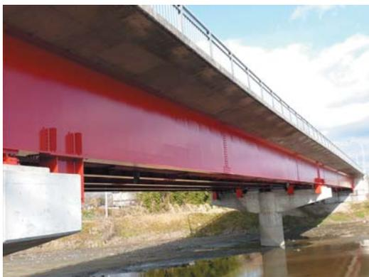
「シントーマイルドシステム」は、光化学オキシダント発生の影響が少ない弱溶剤（ミネラルスピリット）を使用し、鉛・クロムなどの有害重金属を含まない環境に配慮した防食塗装システムです。
