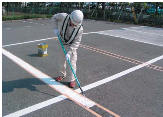
ローラー施工
