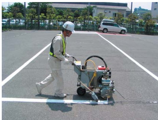
専用塗装機（ハンドマーカ）施工
