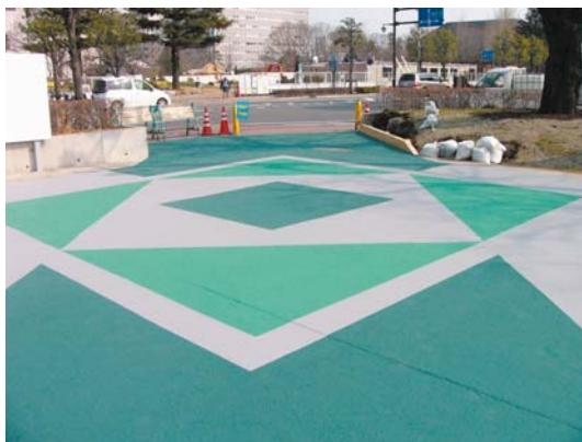
「SPリフレクターW」は、太陽光の近赤外線領域の波長を効率的に反射する特殊な顔料を配合し、アスファルト舗装などの路面温度の上昇を抑制する速乾性の水性遮熱カラー舗装材です。
