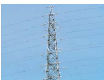
「ガルバタワーL-L」システムは、長期の保護性能で亜鉛めっき鉄塔の延命化を図ります。
