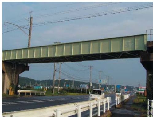
▲下塗「水性さびコート」(上塗「水性ポリン」を使用)
