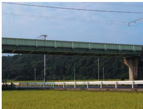
▲上塗「水性ポリン」(下塗「水性さびコート」を使用)
